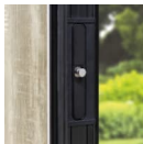
Dreidimensional verstellbares Schließteil im Türflügel
